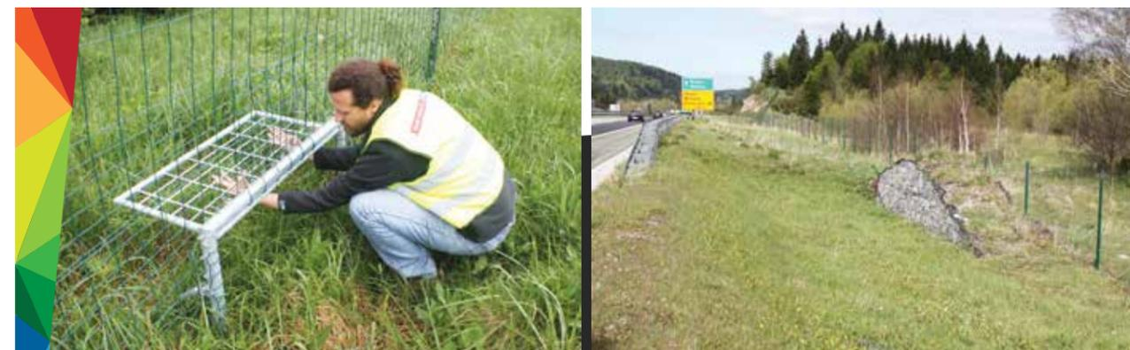
*Le misure che facilitano la fuga degli animali dalle aree chiuse delle vie di comunicazione, come i cancelli di uscita a senso unico e le rampe di uscita, riducono la probabilità di collisioni con i veicoli (Huber Đ.).*
