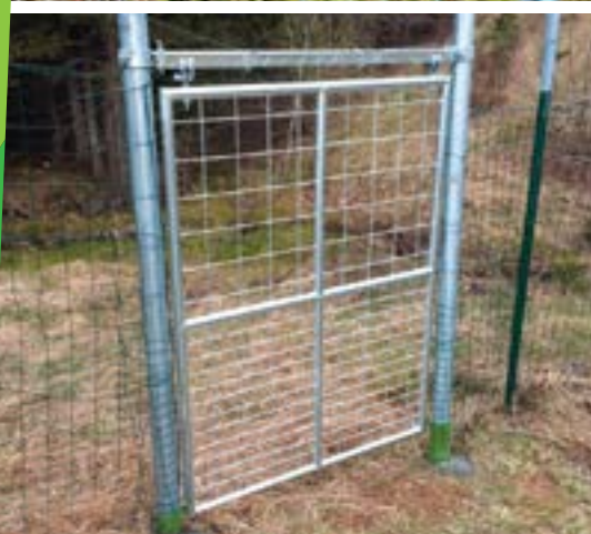
Lijevo: ugradnjom jednosmjernih izlaznih vrata za izlaz životinja s ograđenih površina na autocesti Zagreb – Rijeka dodatno se povećala sigurnost u prometu Desno: instaliranje električnih ograda sprečava prelaženje medvjeda preko zaštitne ograde/mreže te ih usmjerava na sigurne prijelaze (Huber Đ.)
