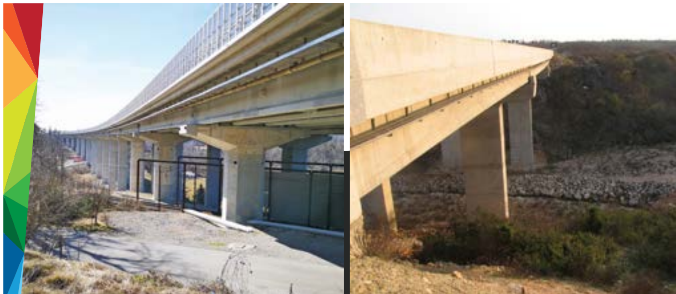
Niski viadukti, kao na primjer kod Unca (Črtalič J.) (SLO) i Baštica (Huber Đ.) (HR) su znatno prohodniji za životinje od nasipa.
