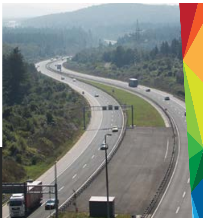
Ograđene autoceste među najvećim su faktorima fragmentacije prostora. Autocesta A1 Zagreb – Split siječe stanište risa i ostalih velikih zvijeri u Dinaridima. (Huber Đ.)
