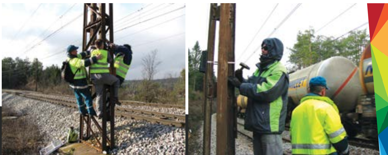
Postavljanje zvočnih odvrtačal na kritičnih odsekih železnice na relaciji Rakek – Postojna in Postojna – Prestranek. (Zaluberšek M.)
